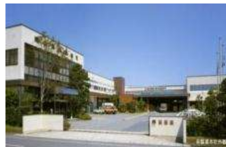
寿製菓(株) 本社工場
